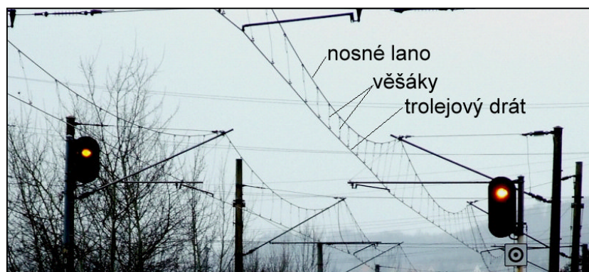
Obr. 1: Základní části trolejového vedení
